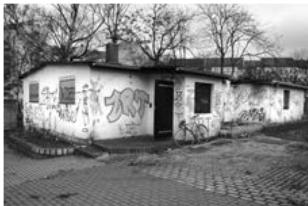
Abb. 13: Das Gebäude auf dem Grundstück Torgauer Straße 24-25 im Februar 2013 Foto: Andreas Bräutigam
