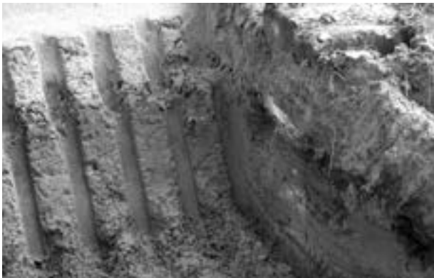
Abb. 11: Baggersondierung auf dem Grundstück Torgauer Straße 24-25. Abgesehen von einer schmalen Bodenschicht mit Anteilen von Bauschutt und Kohlenresten (schwarze Färbung) besteht der Untergrund aus Sand und enthält keine schützenswerten Fundamente. Foto: Andreas Bräutigam
