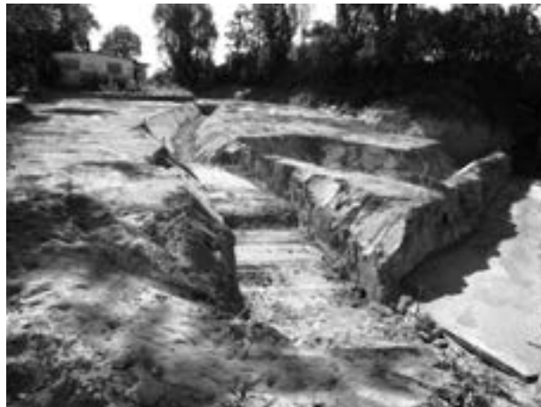
Abb. 10: Das Grundstück der ehemaligen Kohlenhandlung musste abgegraben werden, um das Fundament für die neue Stützmauer zur Gotenstraße hin (rechts im Bild) und die Grube für die Entwässerungsrigole zu erzeugen. Nach Errichtung von Stützmauer und Rigole wird die Erde schichtweise auf die alte Höhe wieder aufgefüllt. Foto: Egon Zweigart
