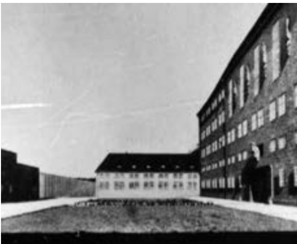
Abb. 31: Zuchthaus Brandenburg/Görden. Hinrichtungsstätte im ehemaligen Garagentrakt Quelle: Archiv Dokumentationsstelle Gedenkstätte Zuchthaus Brandenburg-Görden
